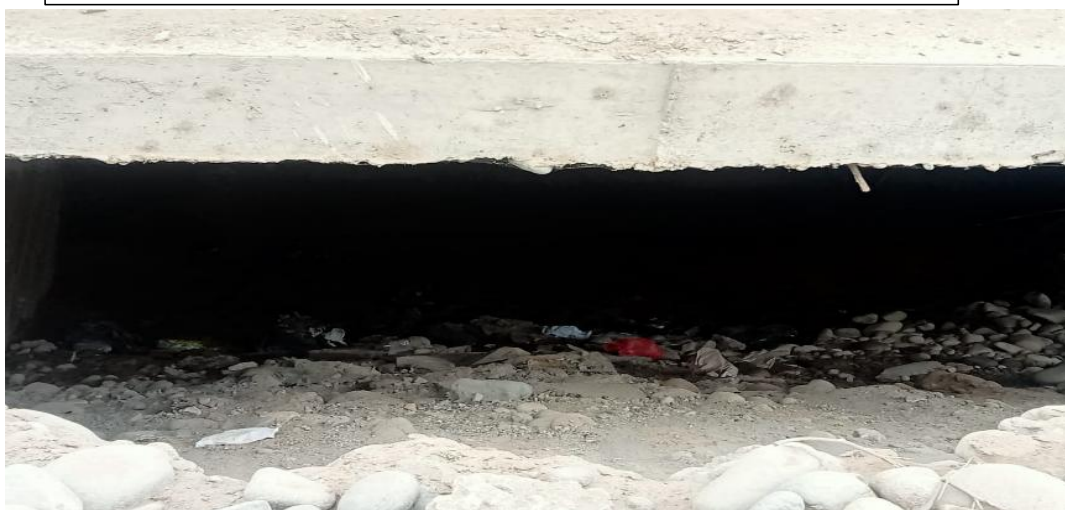
FIGURA N°03: EN LA TEMPORADA DE MAXIMAS AVENIDAS, EL RÍO PISCO HA AFECTADO ESTA MARGEN DEL SECTOR HUAMANI, EN LA CARA SECA DEL MURO DE CONCRETO, CERCANO A AFECTAR EL CAMINO CARROZABLE Y PREDIOS.
