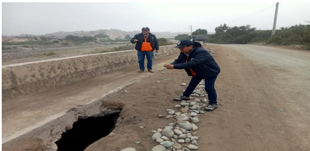
FIGURA N°02: MARGEN IZQUIERDA DEL RIO PISCO SECTOR HUAMANI, SE HAN REALIZADO SOVACONES EN LA CARA SECA, PONIENDO EN RIESGO EL CAMINO CARROZABLE Y LUEGO AREA AGRICOLA EN DICHO SECTOR.
